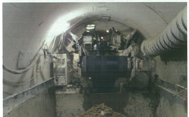
Foto 5. Cinta vertiendo en la vagoneta.
