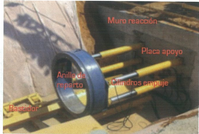
Fotografía 2. Equipo de empuje. Fuente: Conducciones y Vías
